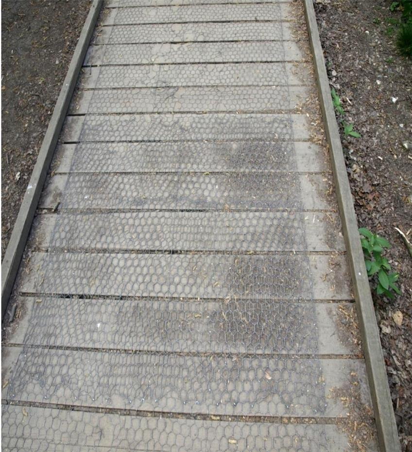
Le problème des passerelles et autres pontons, outre leur solidité, est le risque de dérapages par temps humide et verglas.
